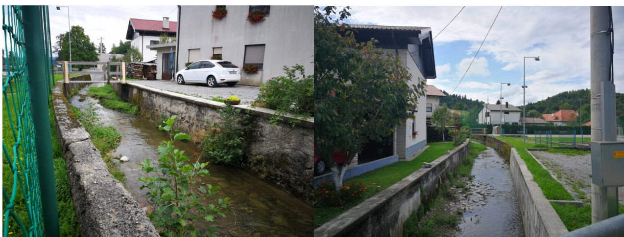
Slika 9: Kanalizirana struga potoka JV od območja OPPN
